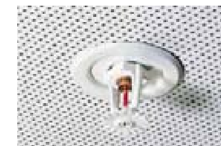
Hlava sprinkleru uchytená v kruhovom výreze
