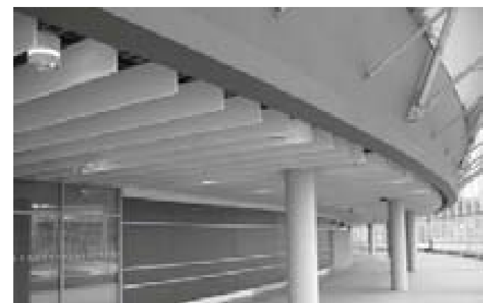
O2 Aréna, Praha 8, kovové baffle Gema
